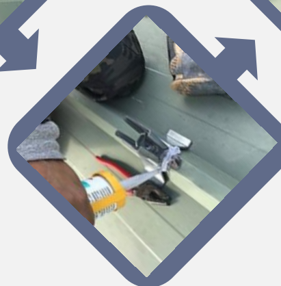
波峰斜面高處 填補矽利康(防漏水)
